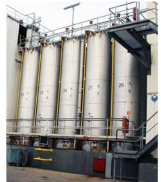
Multi-Tasking-fähig: Freiabstrahlende Radare messen an allen 10 Tanks kontinuierlich den Füllstand und dienen gleichzeitig als Überfüllsicherung.
