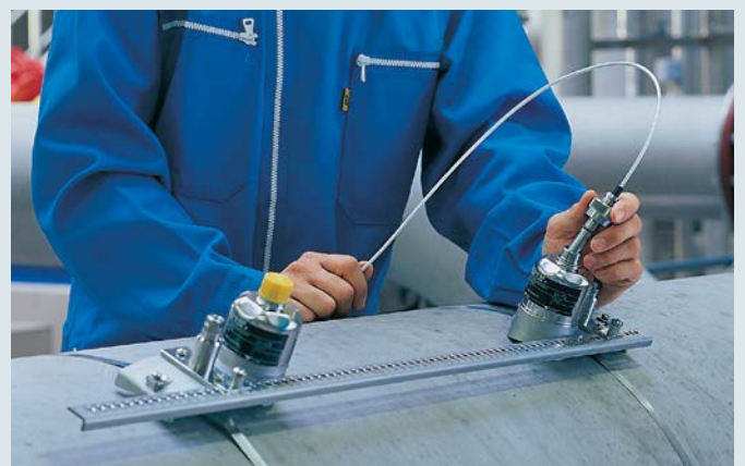
설치된 유량계의 검증
