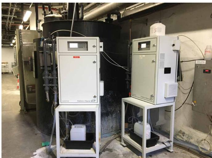
Les deux analyseurs CA72TOC utilisés en sortie du processus de traitement biologique des eaux usées.
