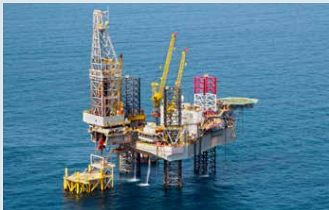
Hydrocarbures liquides, par exemple pétrole brut (on-/offshore)
