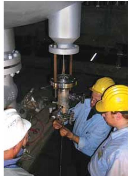
Instalación de un portasondas multipunto
