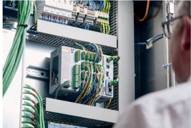
Industrie 4.0 im Schaltschrank: Der Memograph M mit integriertem Webserver gibt dem Nutzer Fernzugriff, um gespeicherte Daten abzurufen oder Feldgeräte zu parametrieren.
