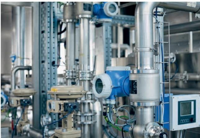
Jeder Energieverbraucher im Sudhaus ist mit Energiezählern ausgerüstet: die Mischbatterie für das Wasser der Schrotmühle mit magnetisch-induktiven Durchflussmessern Promag H und Temperatursensoren.
