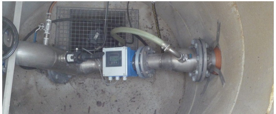
Abwasser-Probeentnahme im Schacht
