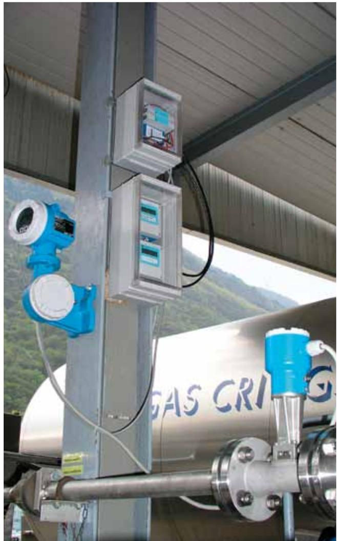
2 appareils Minilog B pour la mesure de niveau et le dosage.
