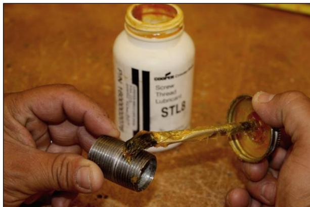
Fig 16. Applying conduit lubricant
