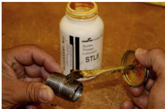
Figura 25. Aplicação de lubrificante nas roscas
