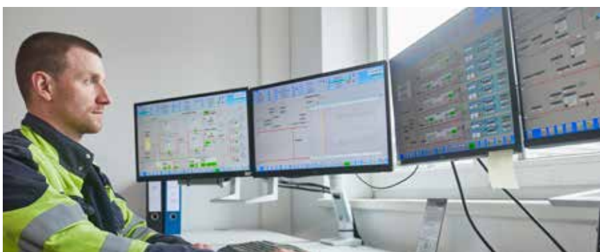
Depuis la salle de contrôle, Florian Wagner peut vérifier le bon fonctionnement des capteurs de pression relative.
