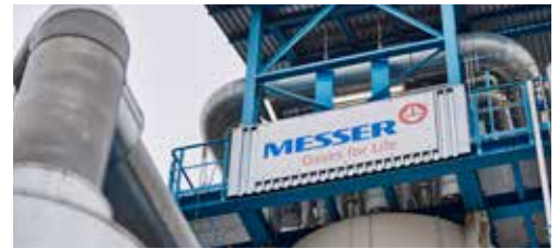
L'usine d'hydrogène de Messer Industriegase.
