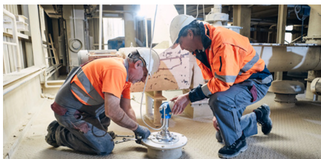
Die Reinigung ohne Druckluft ist mit dem Ausbau verbunden und daher aufwendiger
