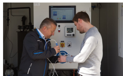
Die Kalibrierung der pH-Elektroden erfolgt dank Memosens-Technologie komfortabel mit dem Handmessgerät CML18.
