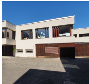
Schulhaus Gemeinde Ettingen
