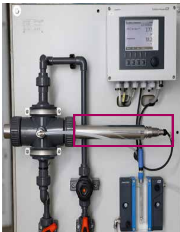
Ploča s Memosens Wave CAS80E i pH kompenzacijom
