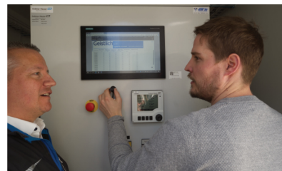
I report preconfigurati possono essere scaricati facilmente tramite un'interfaccia USB sul quadro di comando.
