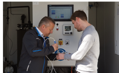
La calibrazione degli elettrodi pH avviene comodamente grazie alla tecnologia Memosens con il misuratore portatile CML18.
