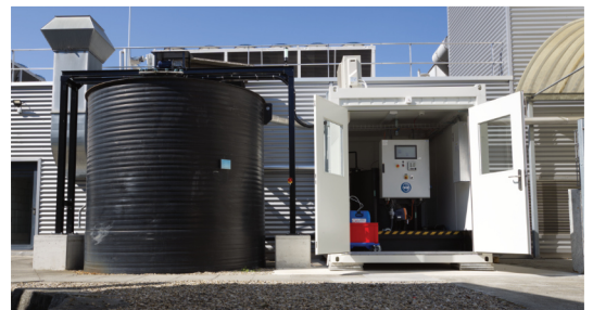
Neutralizzazione compatta in contenitore e serbatoio impilabile con agitatore
