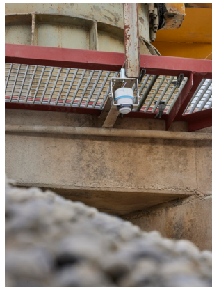
Radar 80 GHz de mesure de niveau
