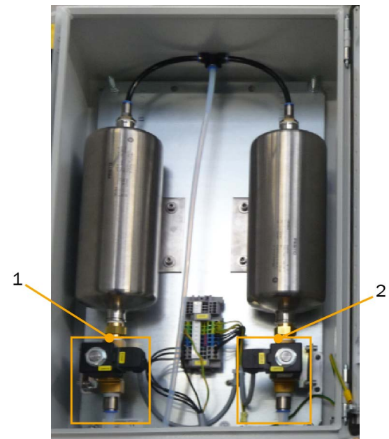
Fig. 6: Unité de rétrosoufflage avec deux électrovannes
