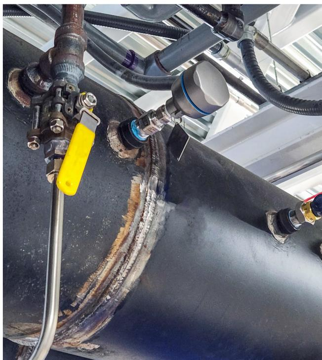
den Betreibern von Rechenzentren oder dem Wartungspersonal, die Temperaturdaten in Echtzeit von einer zentralen Stelle aus zu überwachen, was eine proaktive Wartung und Anpassung des Kühlsystems ermöglicht. Dies kann besonders in großen Rechenzentren nützlich sein, in denen sich das Kühlsystem in einem anderen Bereich der Anlage befindet.
