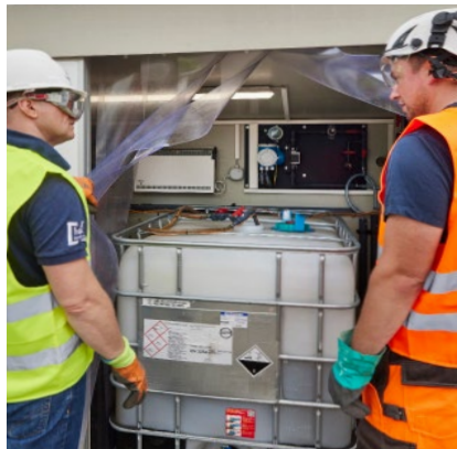
Dank kontinuierlicher Messung kann das Fällmittel bedarfsgerecht dosiert werden
