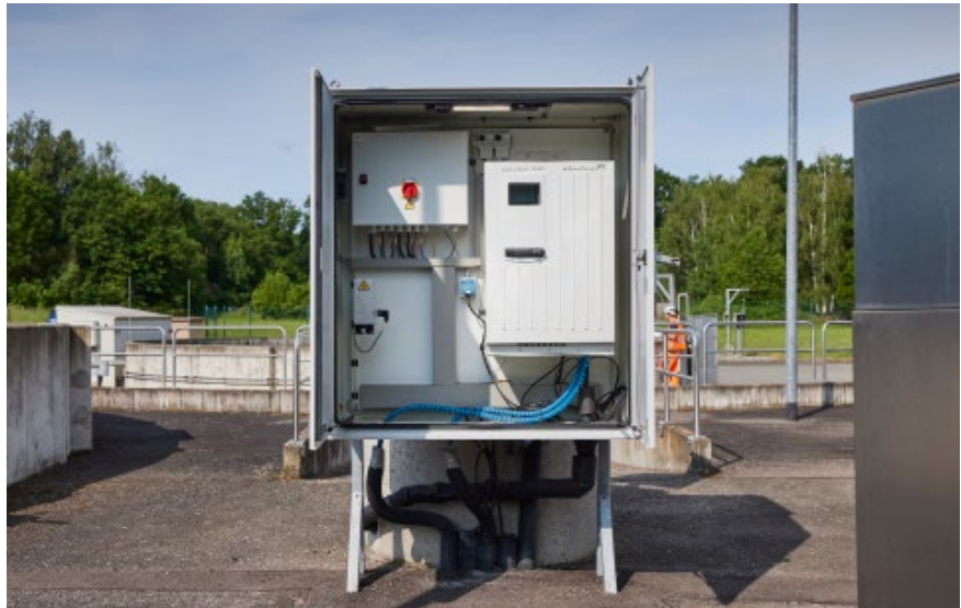
Der Umschrank schützt den Analysator vor äußeren Einflüssen
