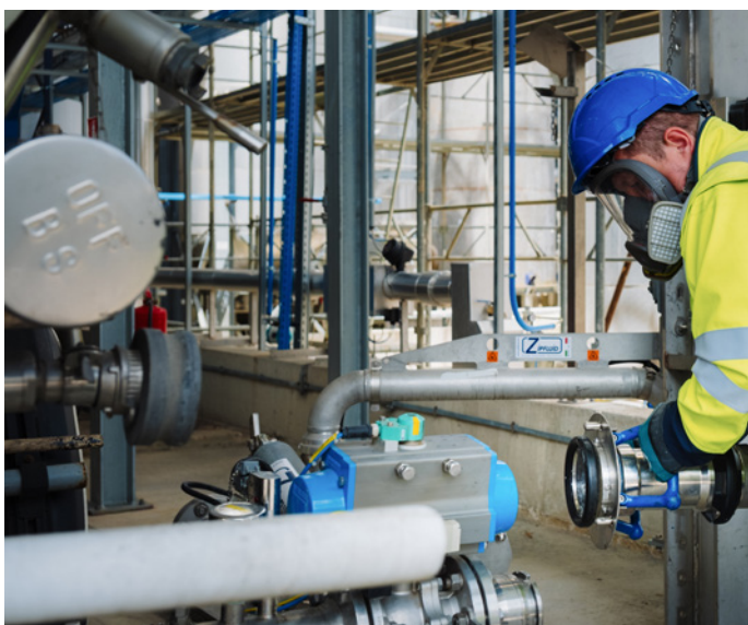
Wenn die Raman-Spektren übereinstimmen, gibt das Überwachungssystem elektronisch eine mechanische Verriegelung frei, mit der die Baugruppe gesichert ist. Danach kann die zweite Komponente von Hand abgenommen und wieder an den Lkw angeschlossen werden.
