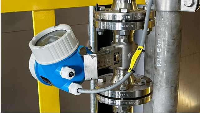
Proline Prowirl F 200 Wirbelzähler-Durchflussmessgerät zur Messung des Dampfdurchflusses
