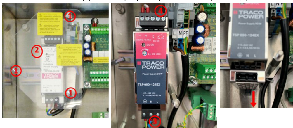
Fig. 51 : Illustrations échange alimentation
