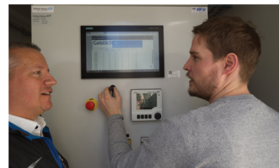
Les rapports préconfigurés peuvent être facilement téléchargés via une interface USB sur l'armoire de commande.
