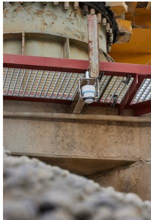
80 GHz Radar-Füllstandsmessung
