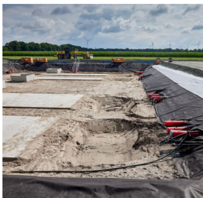
Jeden Kilometer befindet sich eine Muffengrube. Über die Muffengruben werden die Stromkabel in die Leerrohre verlegt.
