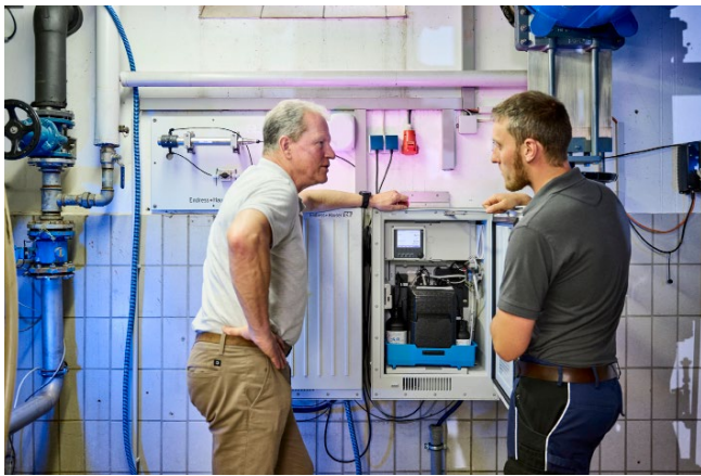
Analysatoren und Nitrat-Sonde zur Überwachung der biologischen Reinigungsstufe
