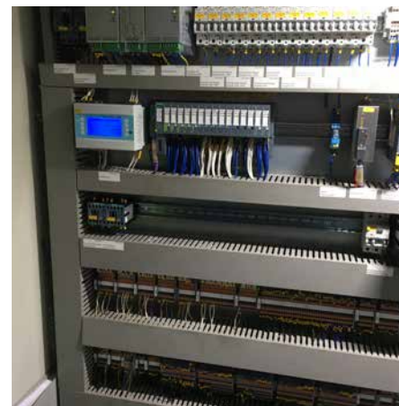
↑ Universeller Durchflussrechner RMC621 zur Ermittlung des Normdurchflusses
