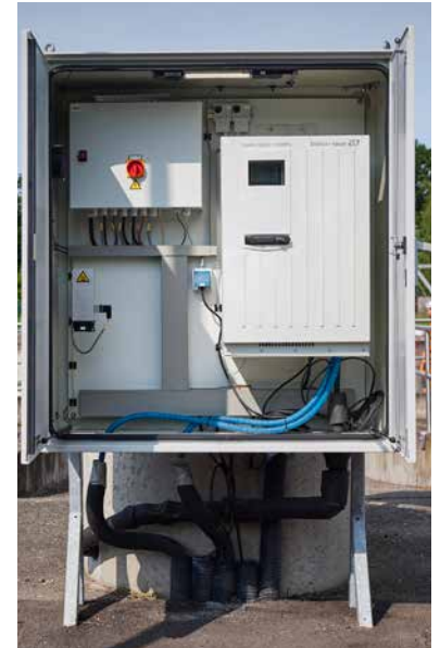
↑ Der Umschrank schützt den Analysator vor äußeren Einflüssen
