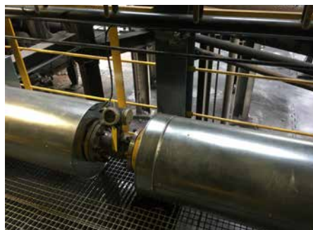
↑ Wasserstoffmessung am Hochofen mit Vortex-Durchflussmessgerät Prowirl plus Druckmessungen Cerabar S
