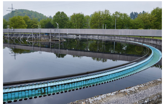
Gestion efficace des réseaux d'assainissement
