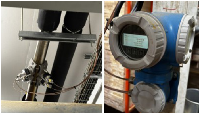
Instalace příložného průtokoměru Proline ProsonicFlow P 500
