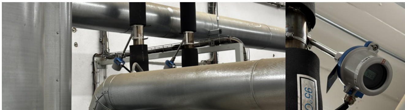
Instalace neinvazivního teploměru iTHERM SurfaceLine TM611
