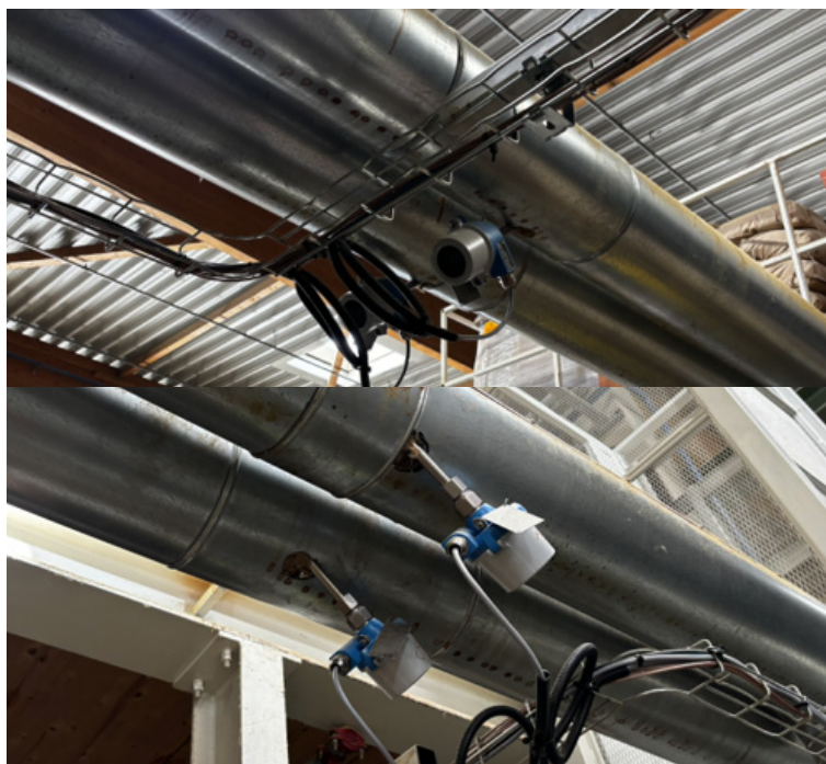
Instalace neinvazivního teploměru iTHERM SurfaceLine TM611
