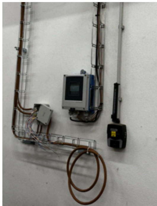
Instalace příložného průtokoměru Proline ProsonicFlow W 400
