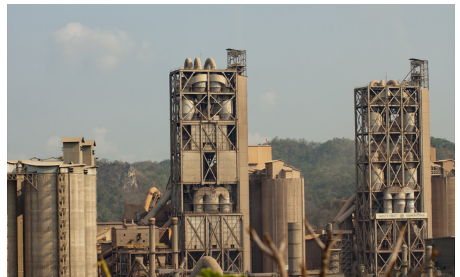
Beispiel eines Zyklons zur Vorwärmung von Rohstoffen
