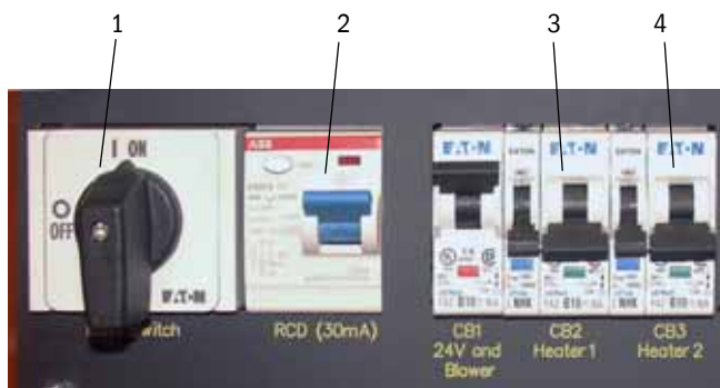
Rys. 66: Odłącznik główny i bezpieczniki w zespole sterowania
