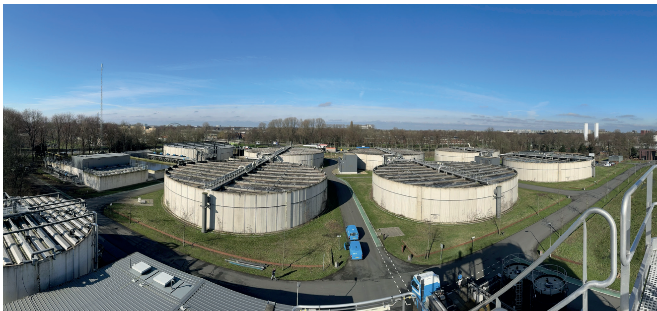
Rioolwaterzuivering Utrecht heeft 6 Nereda® bassins.. Elk bassin heeft een inhoud van 12.000 m 3 .
