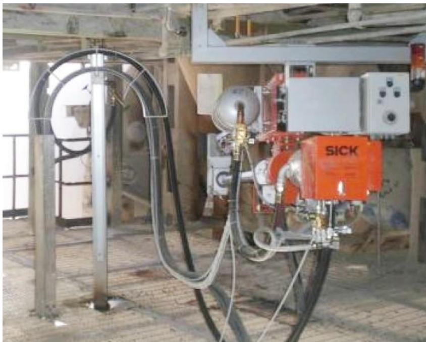
Abb. 31: Schlauchhalterung an einem Mast und auf dem Boden (Beispiel)
