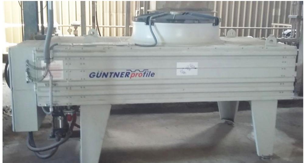
Abb. 40: Wasser-Wasser-Kühlgerät, komplett installiert
