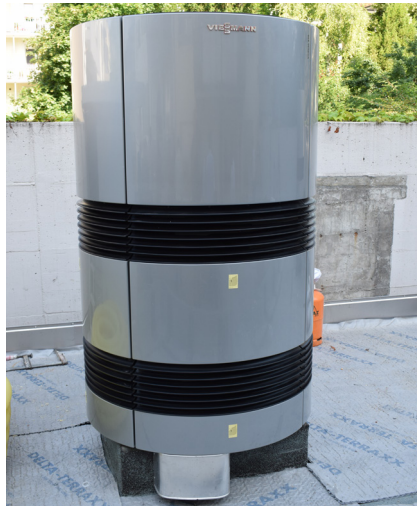
Pompa di calore
