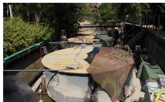
Tanque de piscicultura
