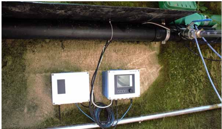
Modbus Edge Device e transmissor de medição Liquline
