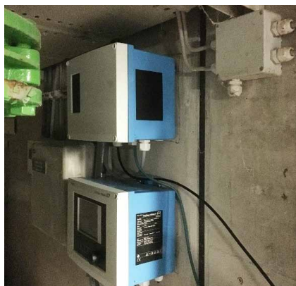
Liquiline CM444 e Modbus Edge Device
