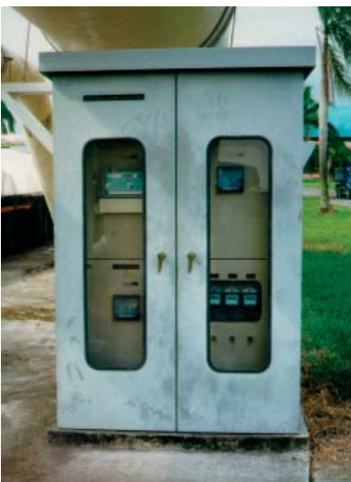
4 equipos Minilog B registran la afluencia de aguas residuales en una gran planta de tratamiento del sudeste asiático.
