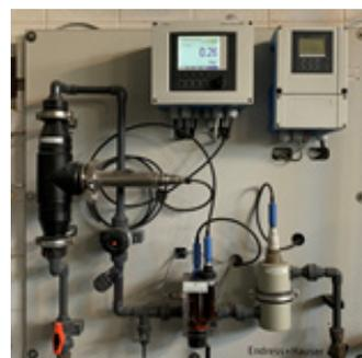
Platine d'analyse pour la mesure du chlore libre en fin de traitement de l'eau potable installée à l'usine de Basse-Vigneulles (à gauche). Memosens CCS51D, capteur de mesure du chlore libre (à droite)
