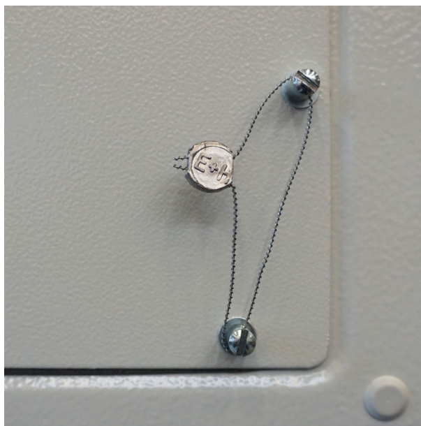
▣ 27 Śruby zaplombowane drutem plombującym
