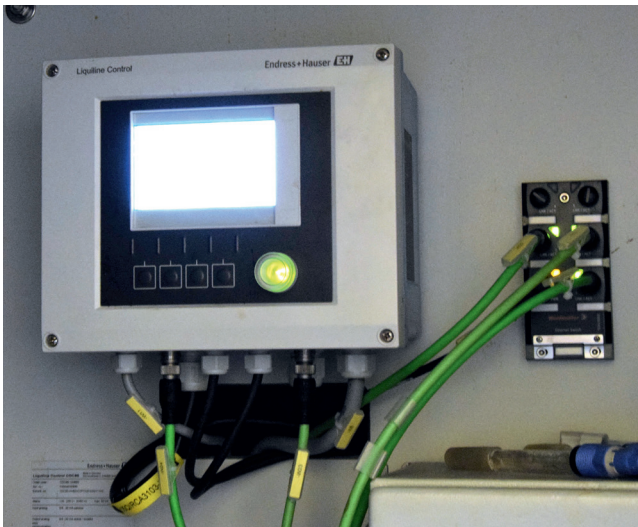
Liquiline Control CDC90 (foto links) en de pneumatische unit voor de geautomatiseerde toevoer van de reiniging- en kalibratievloeistoffen (foto rechts).
