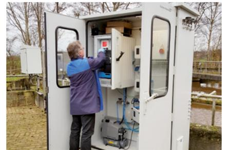
Messstation für Belebungsbecken, Orthophosphat-Analysator CA80PH
