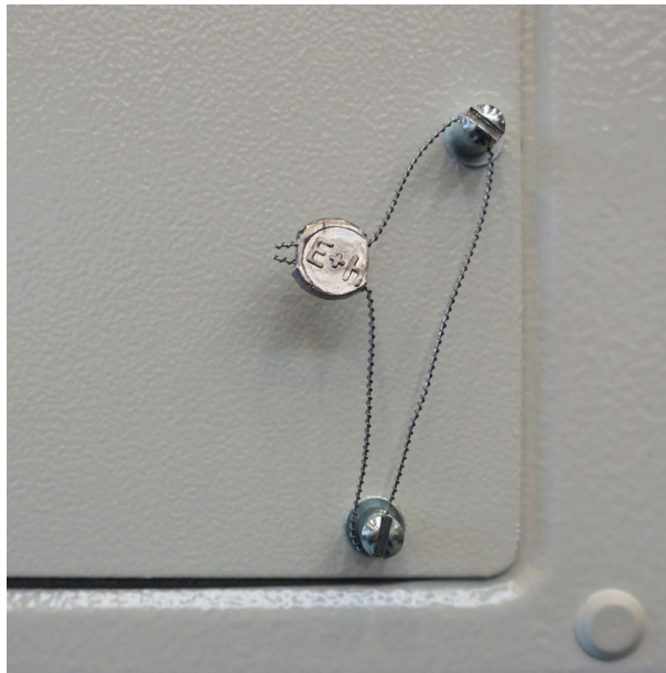
27 Skruer forseglet med forseglingsvaier
