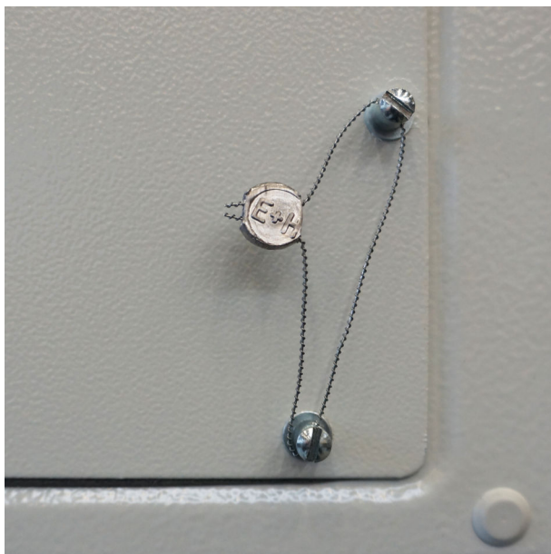
27 Vijci zapečaćeni brtvnom žicom
