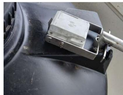
planteó Fribin es que, no quería desarrollar una infraestructura (armario, fuente de alimentación, radio...) para el envío de la información de los niveles a la planta de producción. Por ello, se optó por unos niveles totalmente autónomos: con batería y envío de datos por red telefónica.
