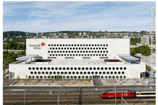
Die Swiss Life Arena in Zürich Altstetten
