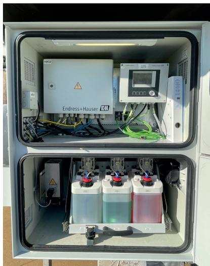
Wichtigste Komponenten im Umschrank: CDC90- und pneumatische Steuereinheit sowie Reinigungsmittel und pH-Pufferlösungen
