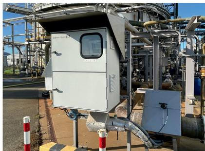
Automatisierte Abwasserüberwachung: CDC90 mit wetterfestem Umschrank sowie beheizter Isolierkappe für Armatur und Sensor
