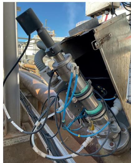
Perfekt für Heavy-Duty-Anwendungen: Die pH-Wechselarmatur CPA473
