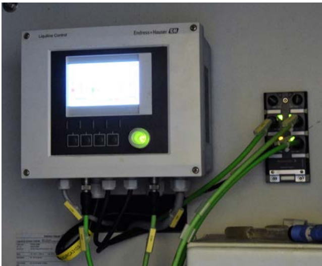
Liquiline Control CDC90 (links) und die pneumatische Einheit für die automatische Zufuhr von Reinigungs- und Kalibrierflüssigkeiten (rechts).
