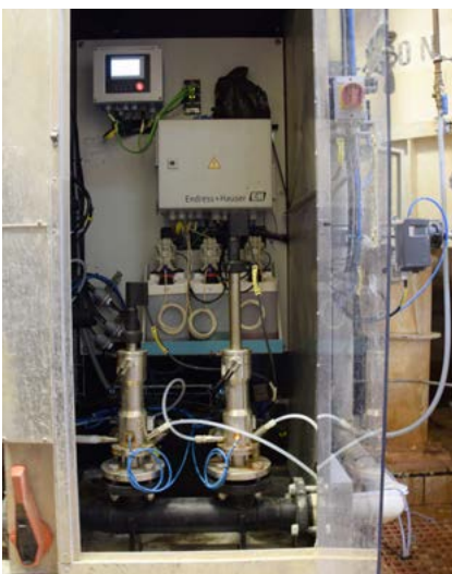
Liquiline Control CDC90 in einem Gehäuse, mit zwei pneumatisch steuerbaren Wechsellarmaturen für pH-Sensoren auf der Vorderseite.
