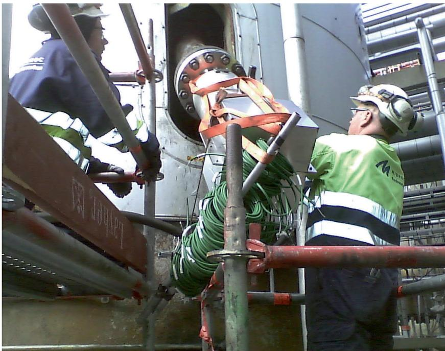
Das iTHERM MultiSens Multipoint-Thermometer mit 27 voneinander unabhängigen Sensoren sorgt für eine effiziente Temperaturmessung im Reaktor.
